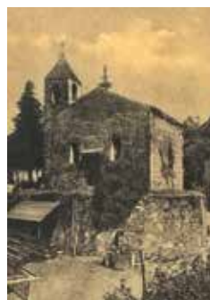
Copertina La chiesetta di S. Ermete oggi.
