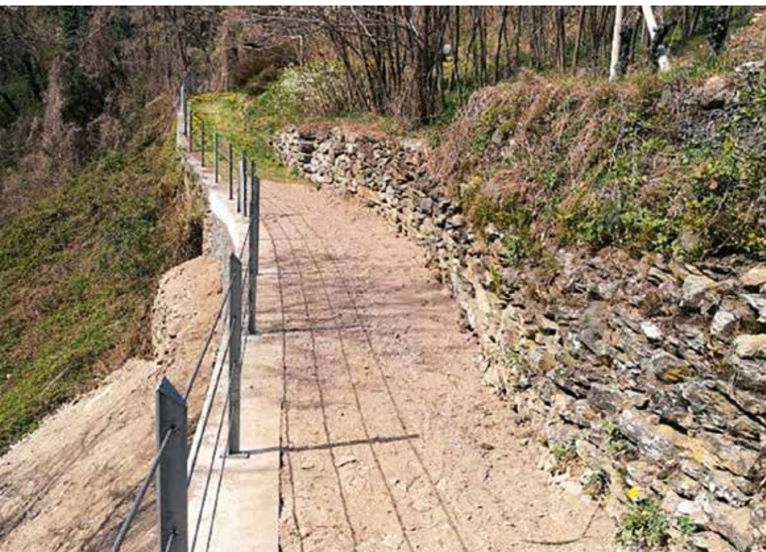
Lavori conclusi al "Sentiero dei 100 scalini"
